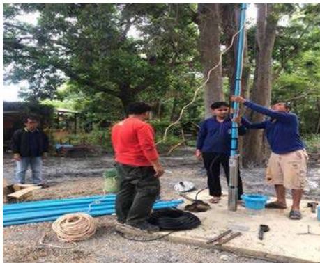
รูปที่ 5.5.2-1 การดำเนินการขุดเจาะบาดาล
