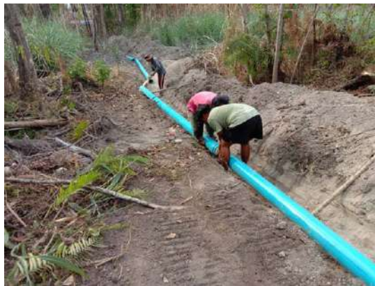
รูปที่ 5.5.1-1 ดำเนินการก่อสร้างระบบส่งน้ำ
